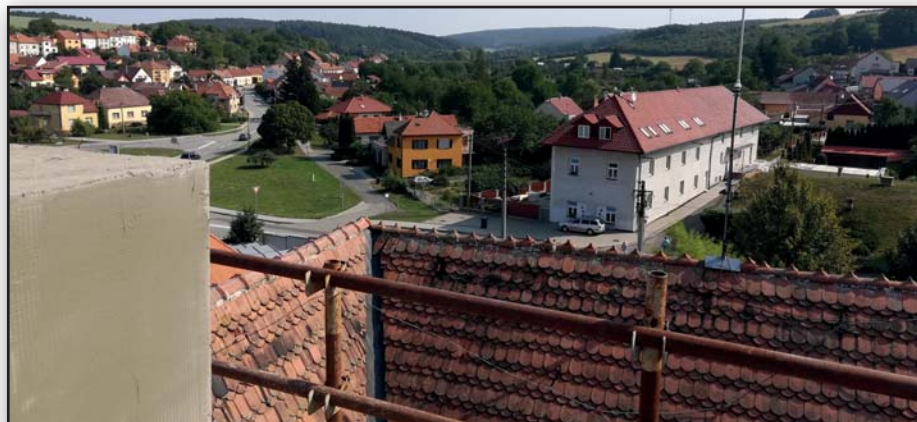
Březolupy z lešení postaveného v rámci rekonstrukce nádvoří zámku
