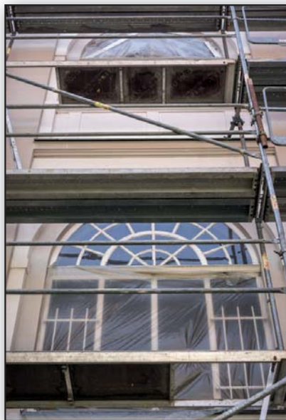
Rekonstrukce nádvoří a výměna oken na zámku
