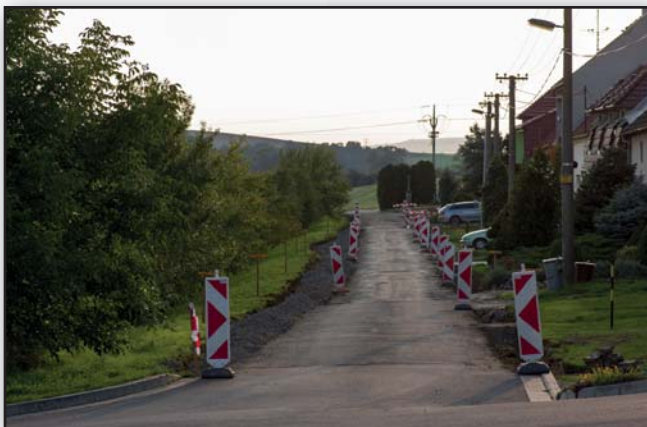
Opravená komunikace v Dolních Šraňkách
