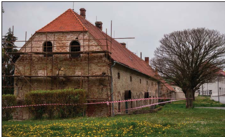
Statické zajištění JZ štítu Podzámčí
