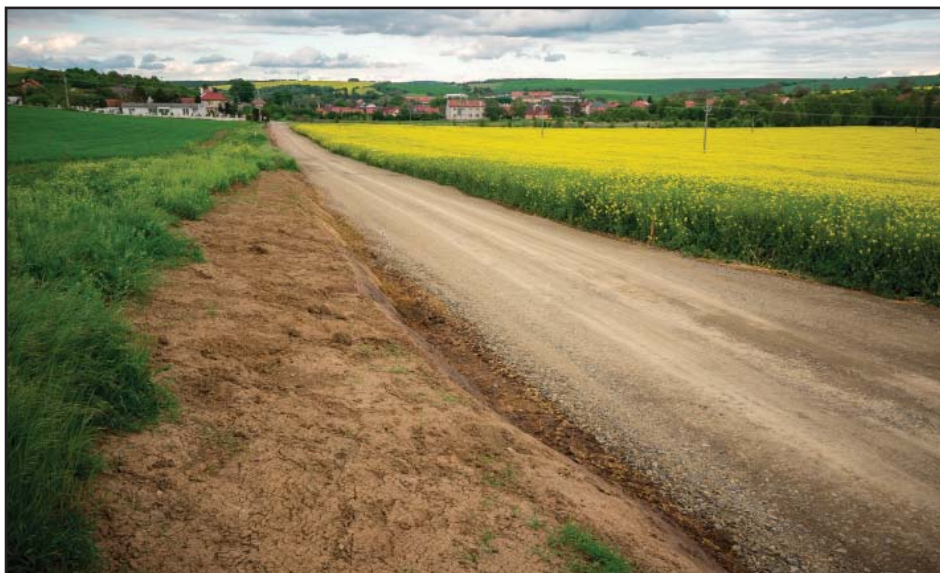
Realizace stavby PC PEO Topolná - Březolupy
